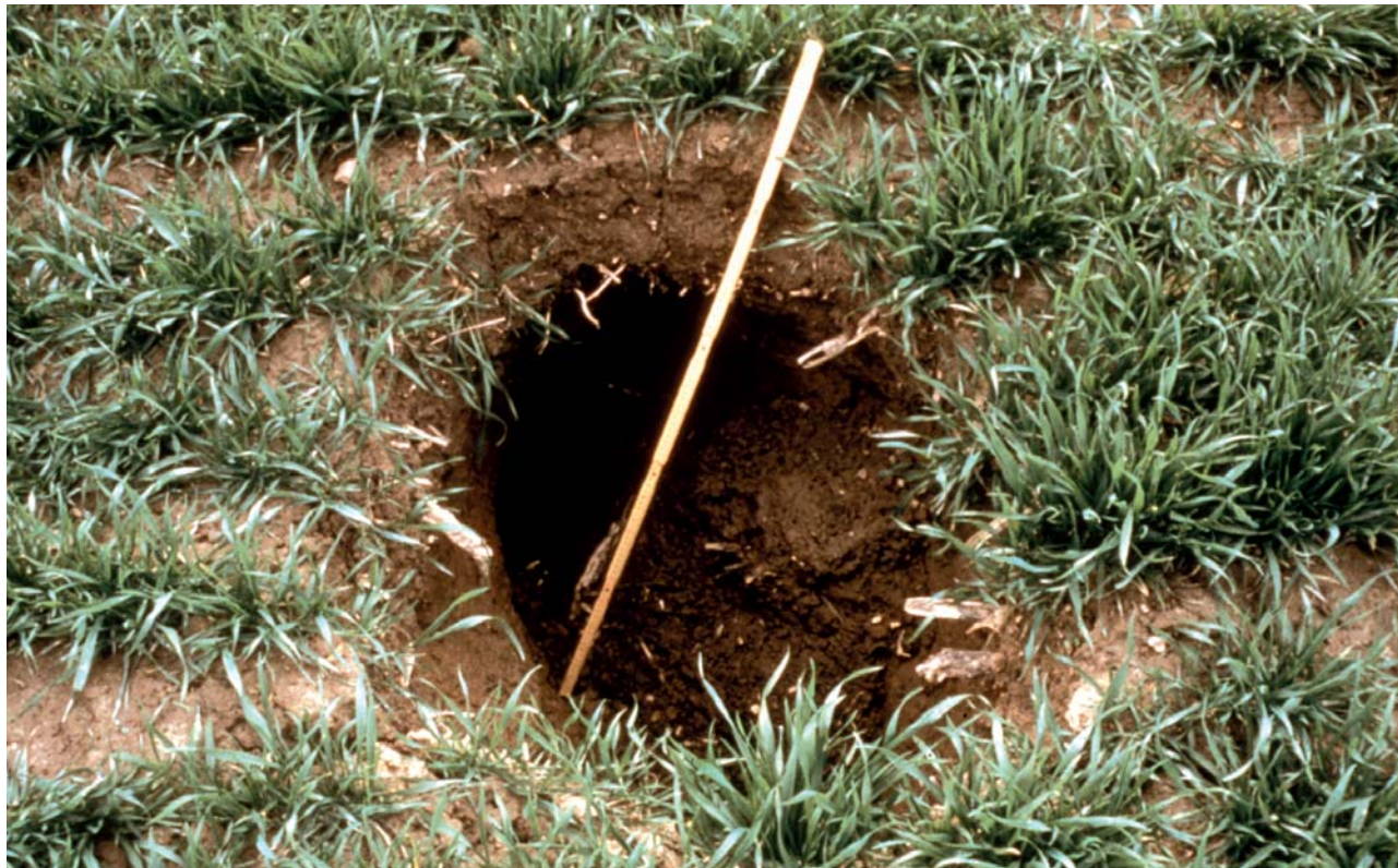
Abb. 15. Erdfall im Brachtal.
